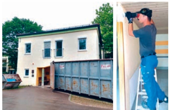
Felix Küpfer half tatkräftig bei der Vorbereitung zur Grundsanierung.
